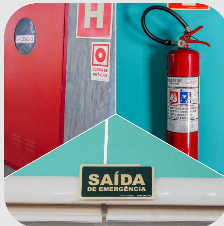
-Segurança (Extintores de incêndio, saídas de emergência, alarmes e hidrantes)
